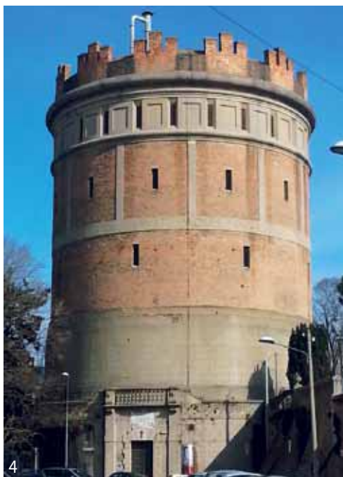
4. Veduta attuale, da viale della Rotonda, della torre-serbatoio e dell'ingresso al sacello.
